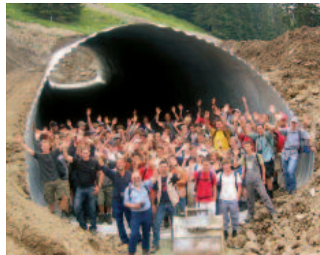
Der «Durchbruch» ist geschafft: Helferinnen und Helfer vor dem 60 Meter langen Tunnel Abendweide, der den Touristen eine gefahrlose Unterführung ermöglicht.
